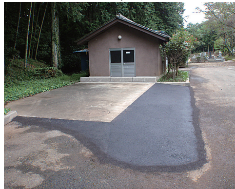
墓地前駐車場 施工後
